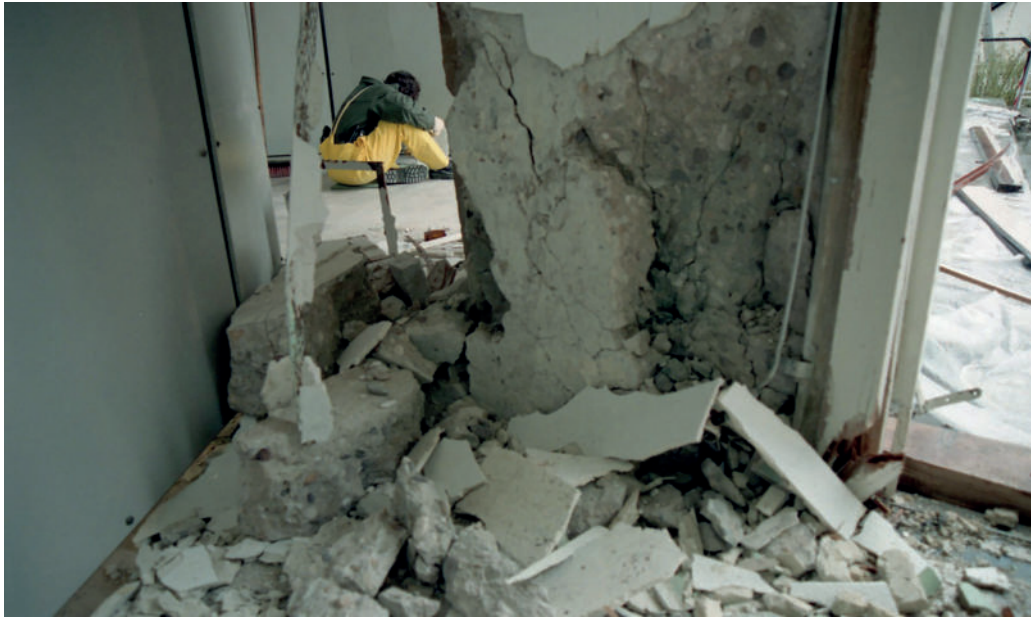
Zwei Kilogramm Sprengstoff verursachten einen Schaden von mehreren hunderttausend Euro (© Becker & Bredel).
