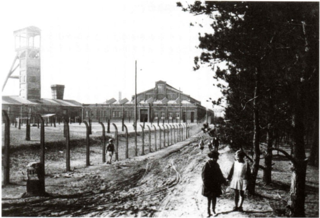
Um die Warndtkohlefelder von Lothringen aus zu erschließen, legte die französische Gesellschaft Sarre-et-Moselle 1921 unmittelbar an der Grenze den Reumaux-Schacht an. Das Foto wurde in den fünfziger Jahren von der deutschen Seite aus aufgenommen. (Fotosammlung Jacques Urek)
