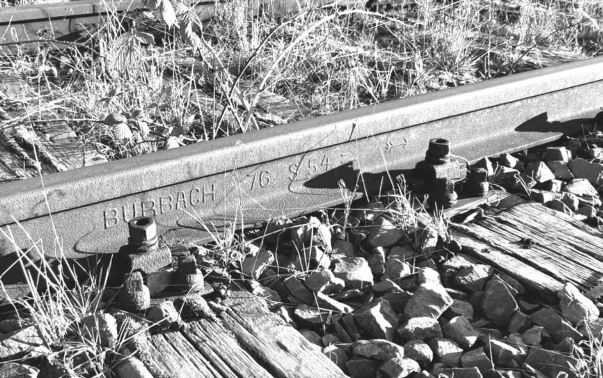
Schiene aus Burbach von 1976 mit einem Gewicht von 54 kg Stahl pro Meter. Foto: Werner Ried
