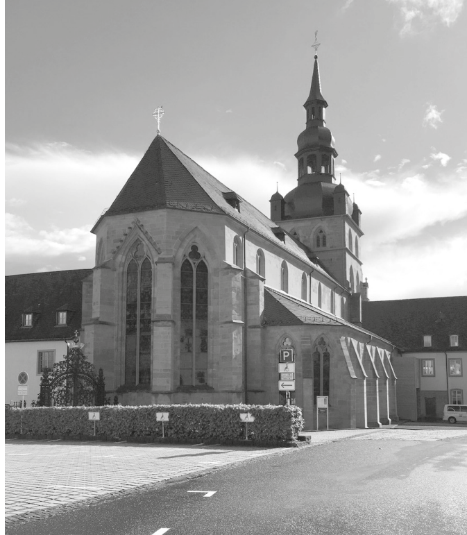
Abteikirche Tholey: Die Kirche nach Ende der Restaurierungsmaßnahmen. Foto: Uwe Loebens
