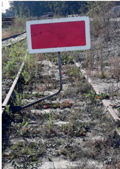
Die Einstellung des Betriebes auf der Primstalbahn steht bevor: zu viele schadhafte Schienen und Schwellen
