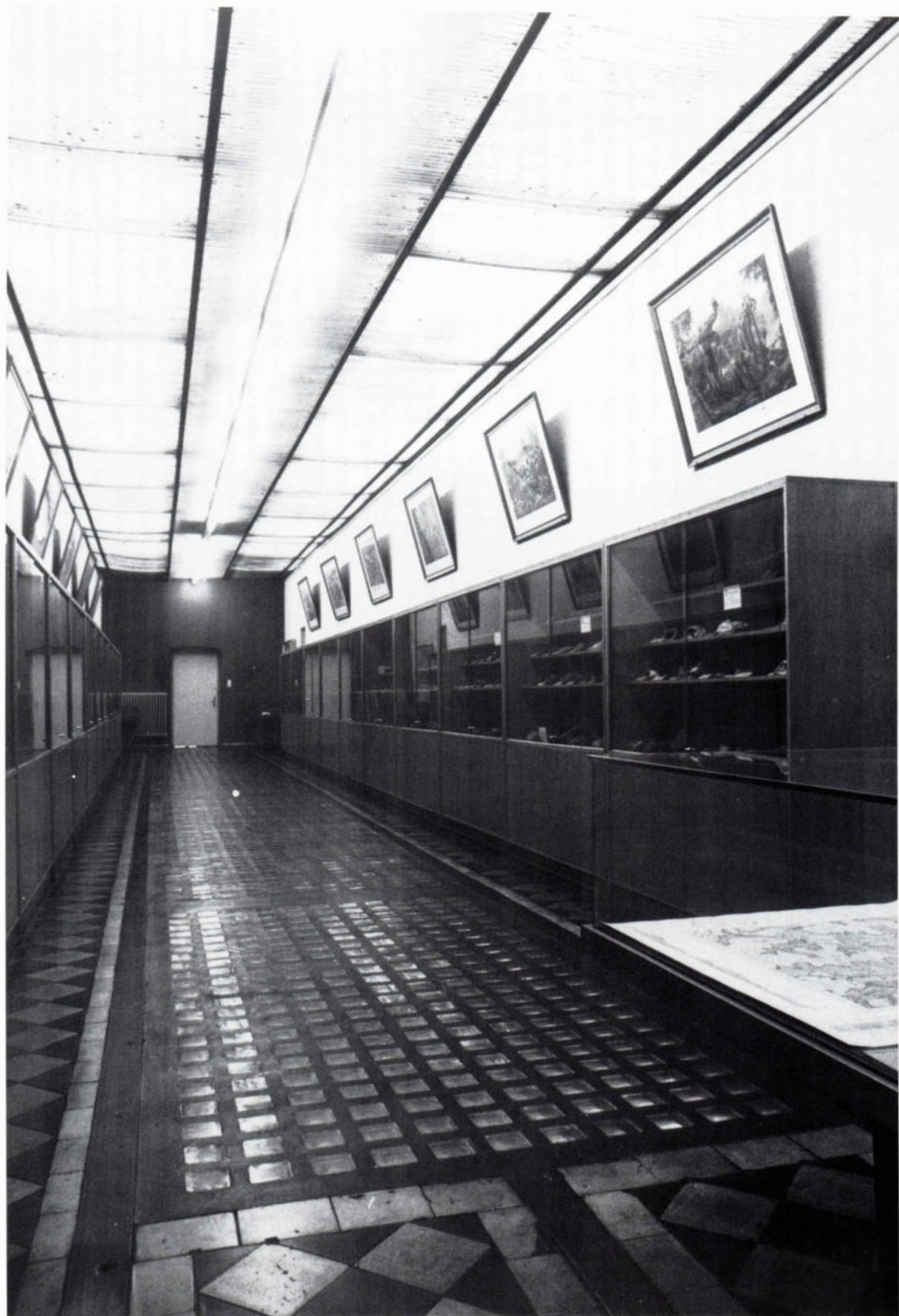
Abb. 40 Schlafhaus- und Kasinogebäude, Mittelgang des Obergeschosses, durch Oberlicht belichtet. Teile der geologischen Sammlung. Auf dem Boden erkennbar die Eisenschienen der „Preußischen Kappen“. Anstelle der Glasbausteine war früher eine Öffnung zur Belichtung des unteren Mittelganges
