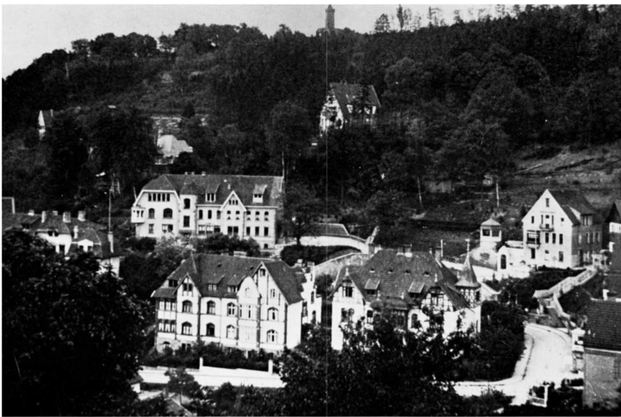
Abb. 5: Teilansicht der Voss'schen Privatstraße am Winterberg Saarbrücken, Haus Winterbergstraße 12 mit dem Erweiterungsbau von 1912.
