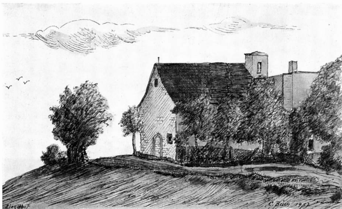
Abb. 17 Die Aschbachkirche vor der Zerstörung im Jahre 1963. Da stand nun dieses, den Jahrhunderten trotze kleine Bauwerk, die sogen. Aschbachkirche bis die heutige Gersweiler Dorfverwaltung sich einfallen ließ, es zu vernichten. Zeichnung C. Büch
