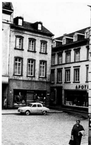
Abb. 5 Haus Ecke St. Johanner Markt/Kronenstraße (links im Bild), in dem 1738 die „neue Fleischbank der St. Johanner Metzgerzunft errichtet wurde. 1863 umgebaut. (Vgl. dazu die Abb. 11–12).
