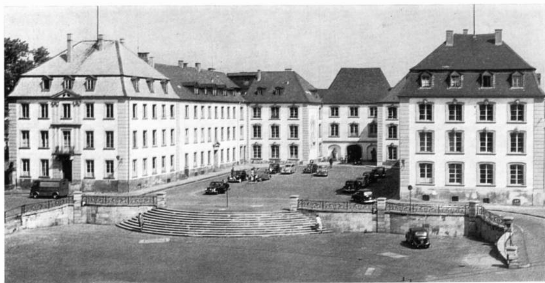
Abb. 24 Heutiger Schloßtorso von 1811 mit den Zutaten von 1938. Die Proportion des Schlosses ist durch den Verlust des Mezzaningeschosses, die Platzfläche durch den Einbau einer Freitreppe gestört.
