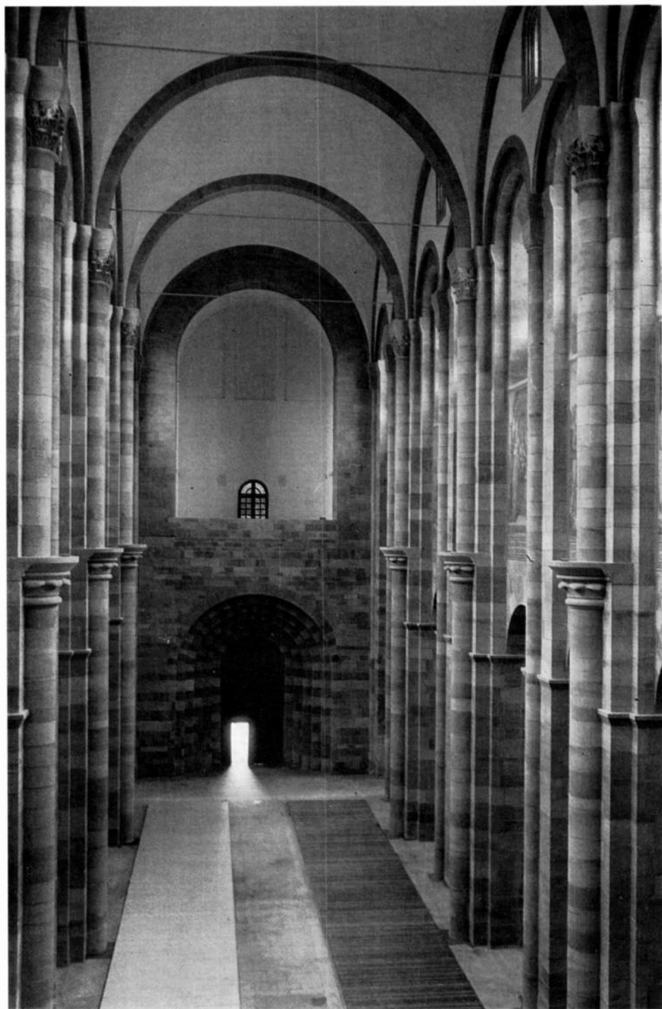
Abb. 20 Mittelschiff des Domes nach der Restaurierung, Blick nach Westen
