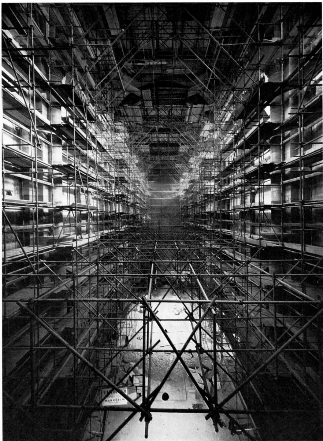
Abb. 21 Mittelschiff mit Gerüst, Januar 1959
