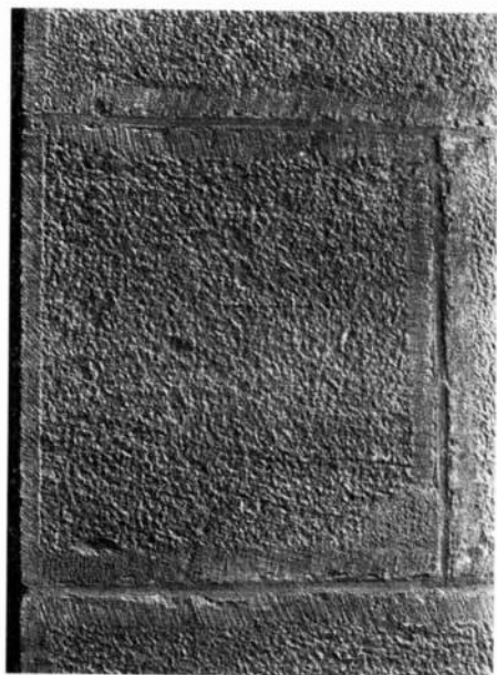
Abb. 22 Gespitztes Quaderwerk vom Bau I
