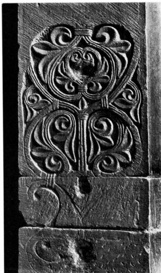
Abb. 24 Querhauskapelle, geflächte Quader vom Bau II mit unvollendetem Ornament
