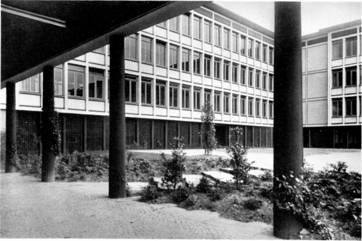
Abb. 11 Ostschule Saarbrücken, Verbindungstrakt – Hofseite
