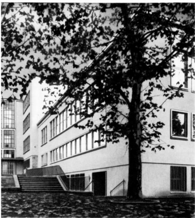
Abb. 1 Weyersbergschule Saarbrücken, Hofansicht
