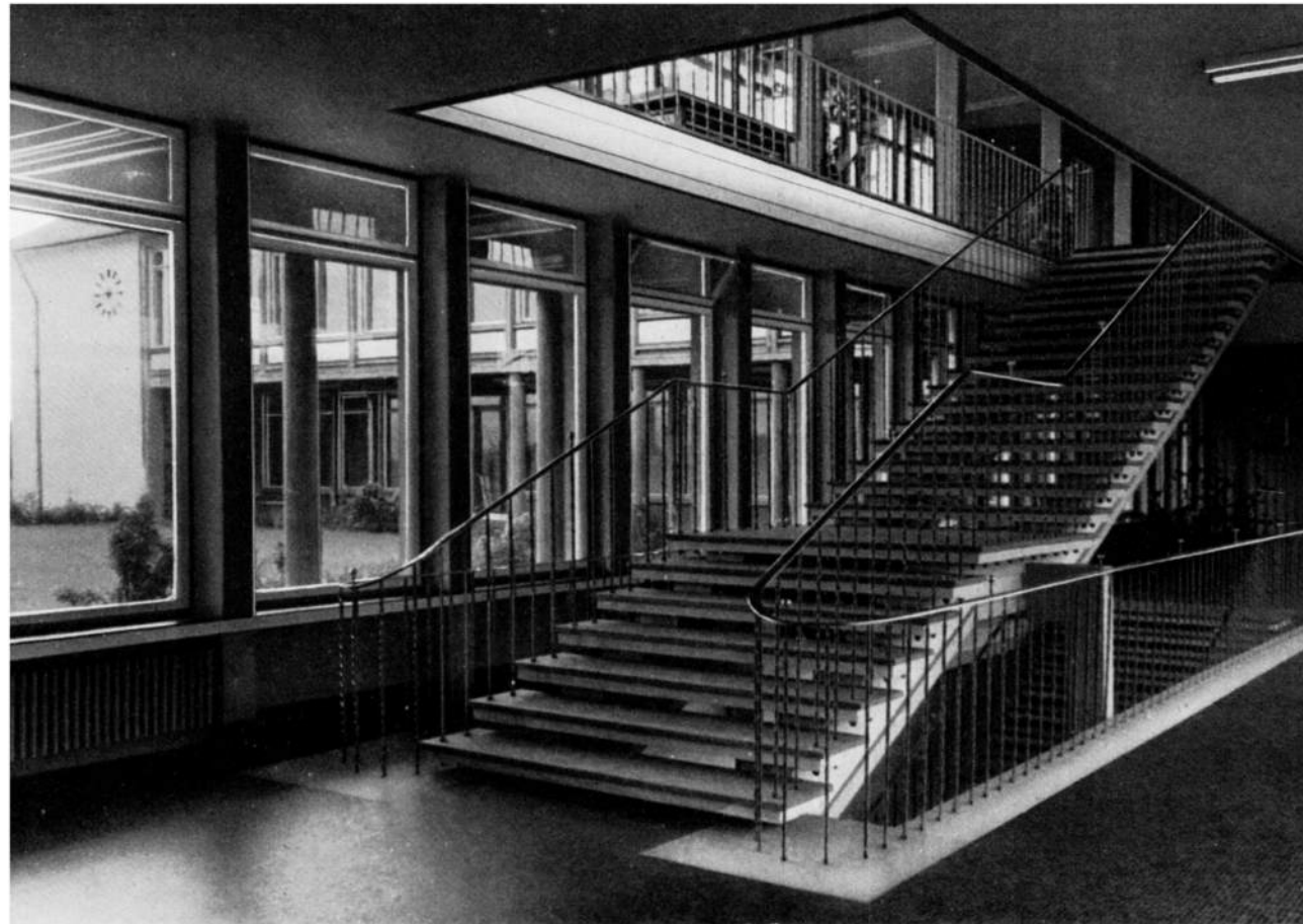
◀ Abb. 8 Knappenrothschule Saarbrücken, Baujahr 1953/54, 1. Bauabschnitt einer 18 klassigen Volksschule. – Klassentrakt und Verbindungsflügel mit Treppenhaus und Pausenhallen
