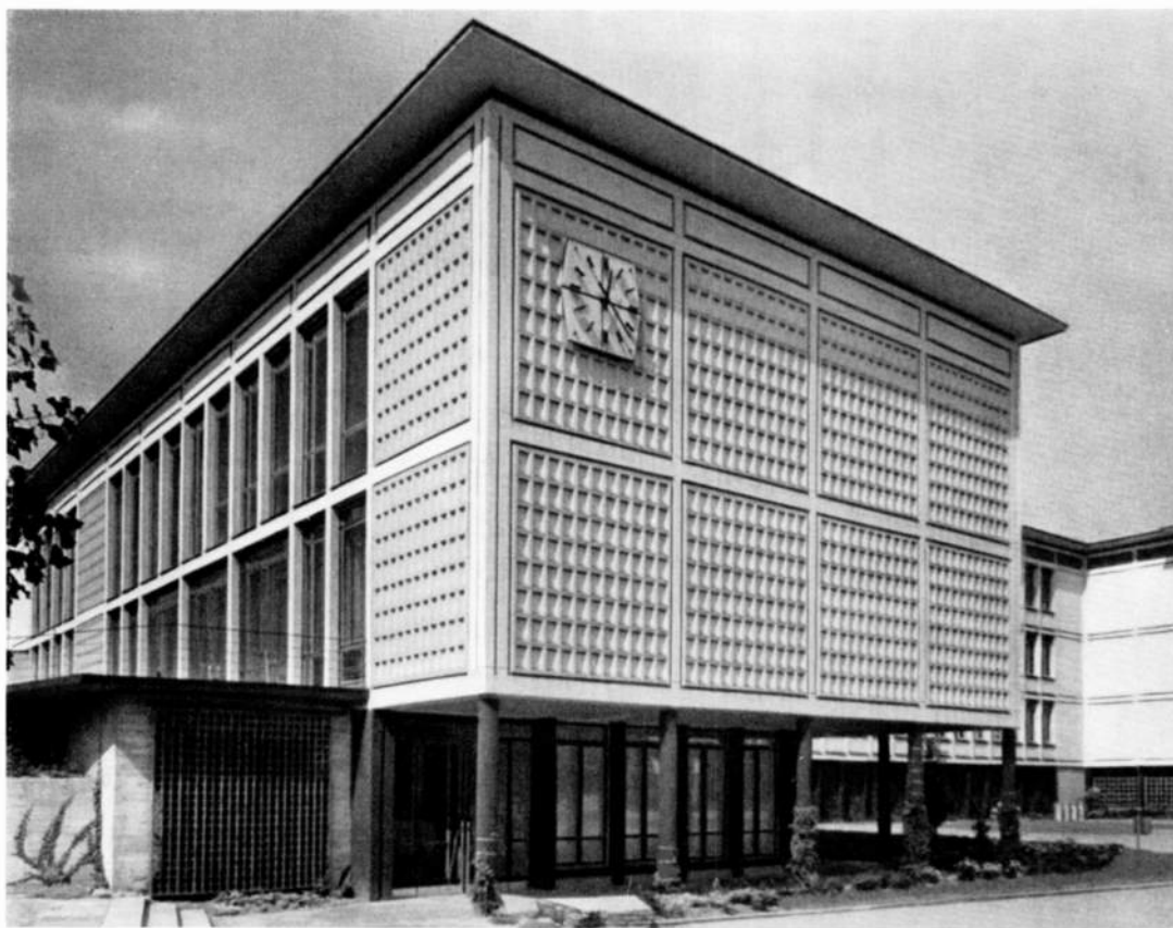
Abb. 13 Ostschule, Turnhallen-Ostseite – Wasch-, Brause- und Umkleideräume im Sockelgeschoß
